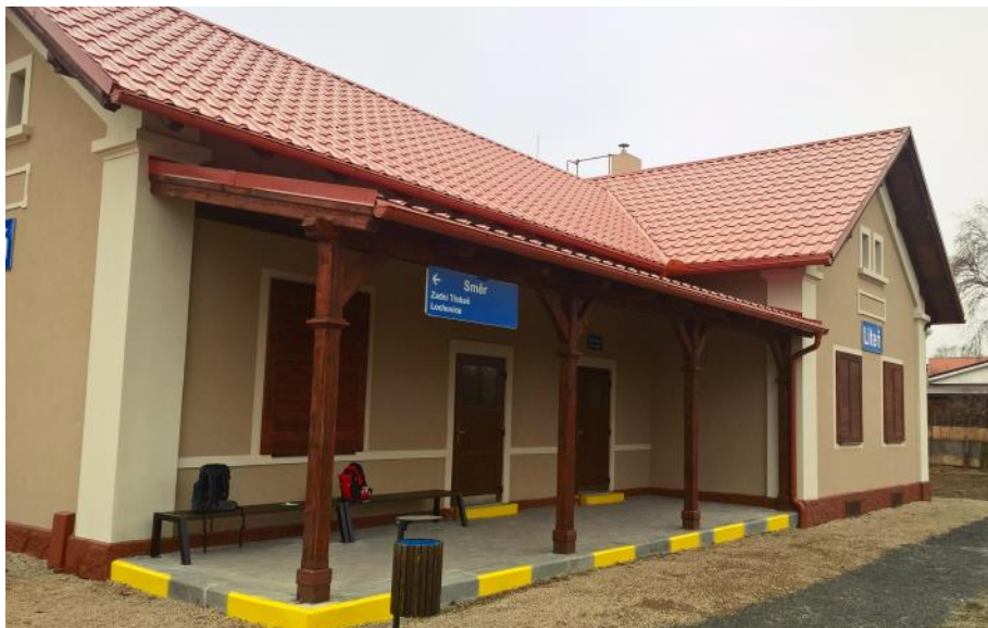
Městys Liteň vyjednával se Správou železnic o opravách budovy železniční stanice Liteň od roku 2018. Prozatímním výsledkem je opravená fasáda a střecha.
