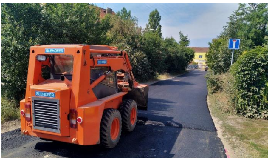
Společně s ulicí Jana Bašty byl opraven i příjezd k mateřské škole v ulici Stará Škola. FOTO: Filip Kaštánek
