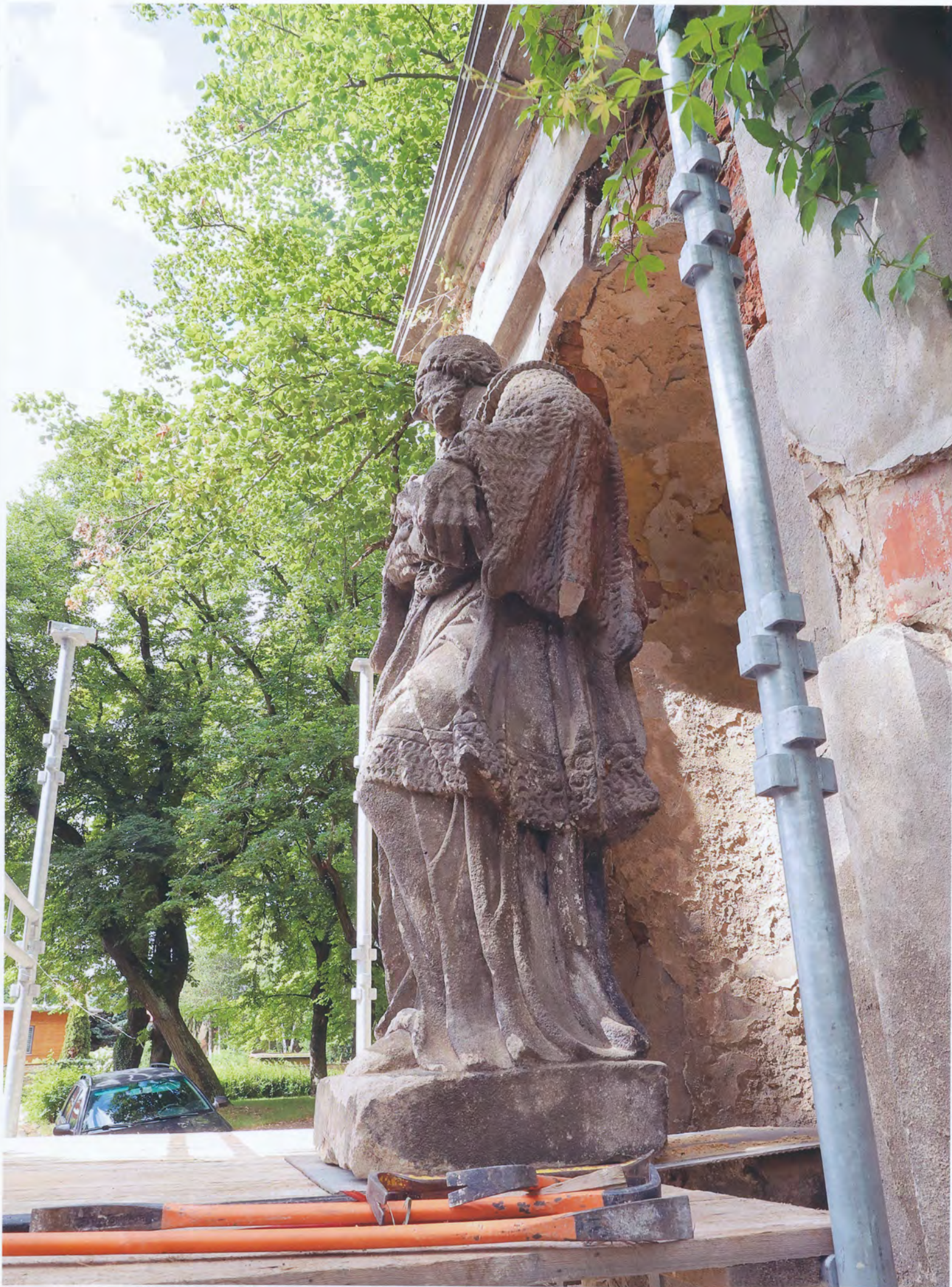
6. Liteň – socha sv. Jana Nepomuckého ve výklenkové kapli – stav před restaurováním, postup prací při demontáži
