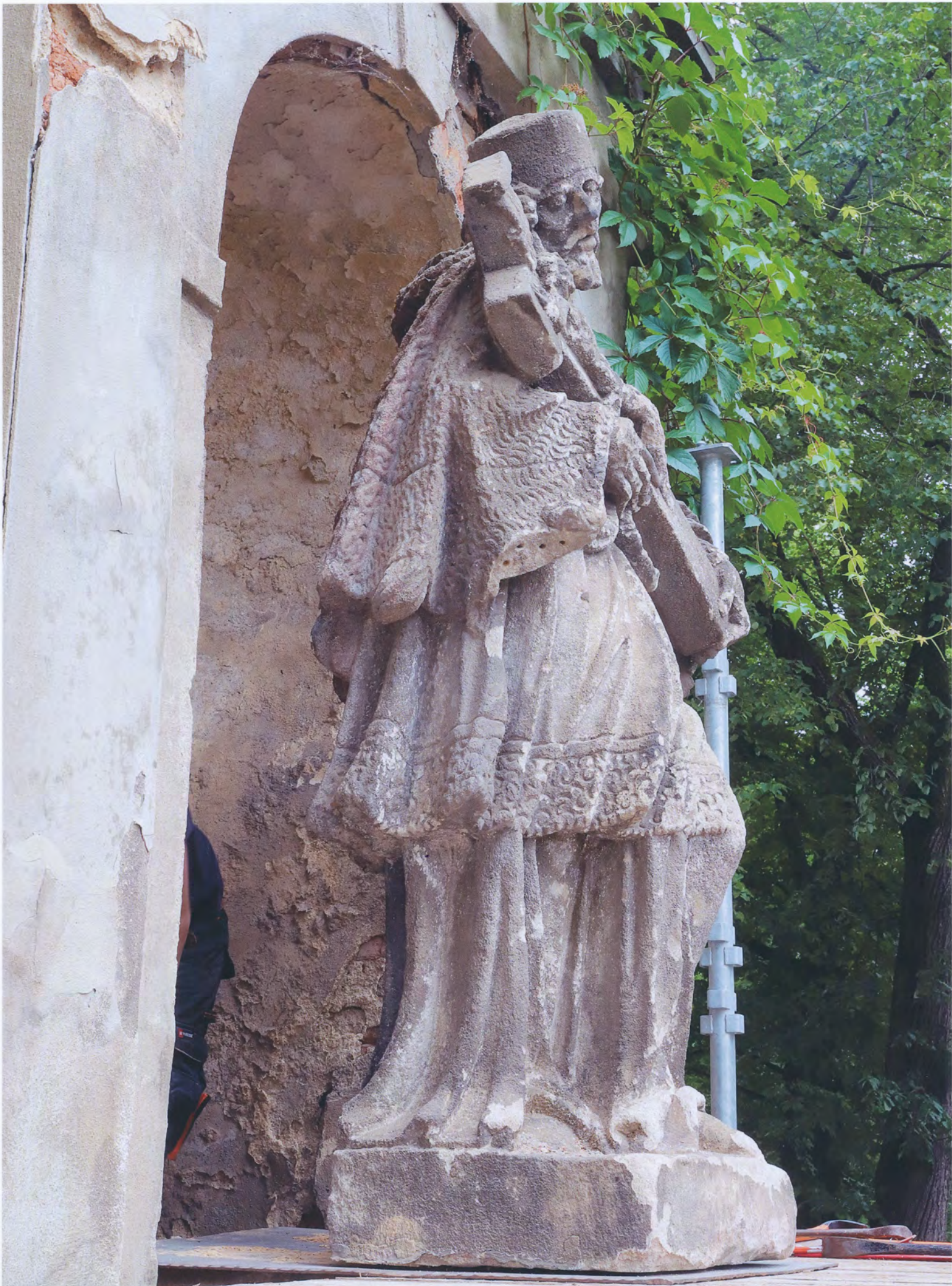
7. Liteň – socha sv. Jana Nepomuckého ve výklenkové kapli – stav před restaurováním – postup prací při demontáži
