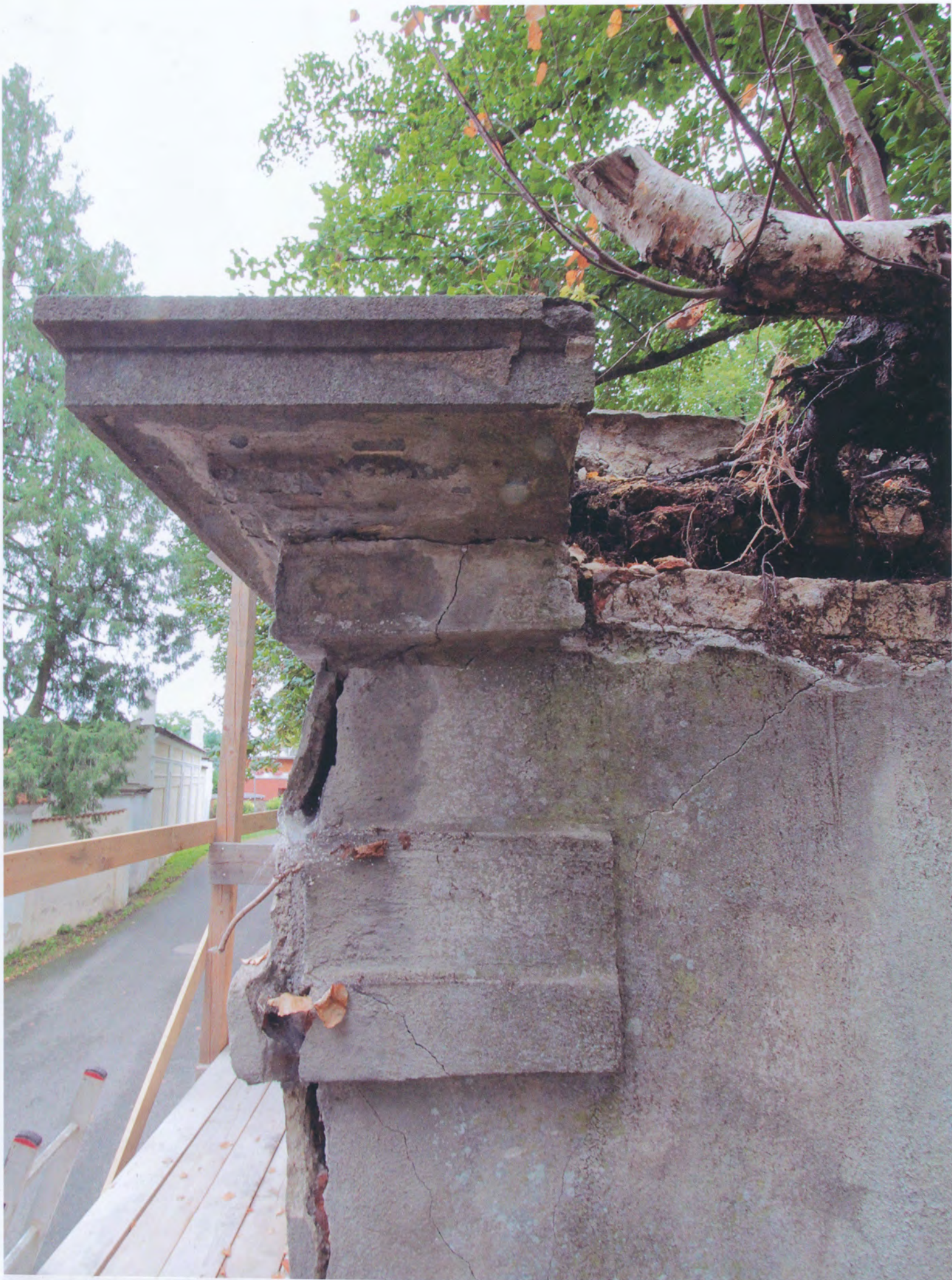
14. Líteň – Výklenková kaple se sochou v ohradní zdi kostela sv. Petra a Pavla –postup prací – odstraňování kořenů břízy
