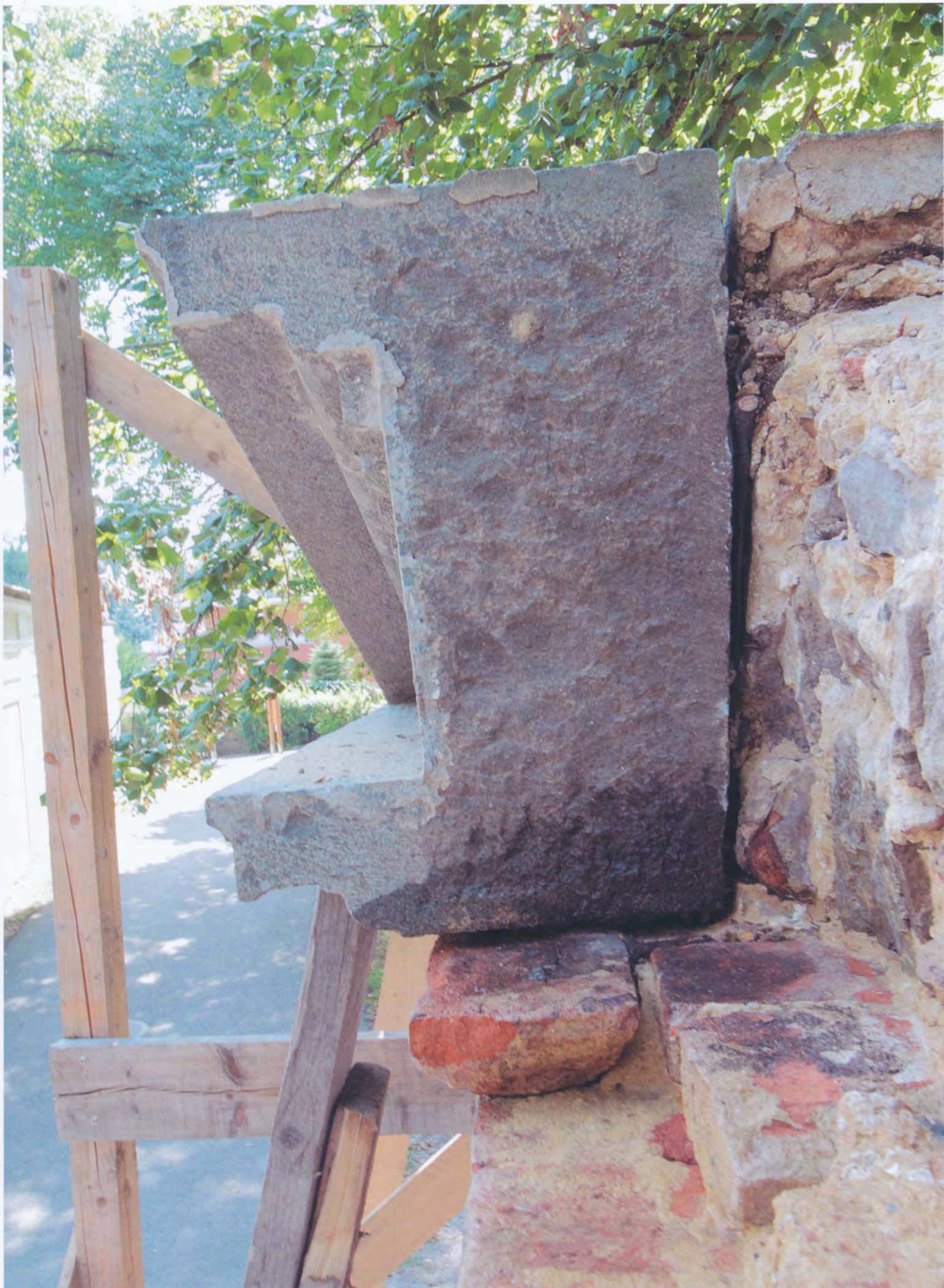
21. Liteň – Výklenková kaple se sochou v ohradní zdi kostela sv. Petra a Pavla – postup prací – demontáž stříšky a odstranění kořenů břízy
