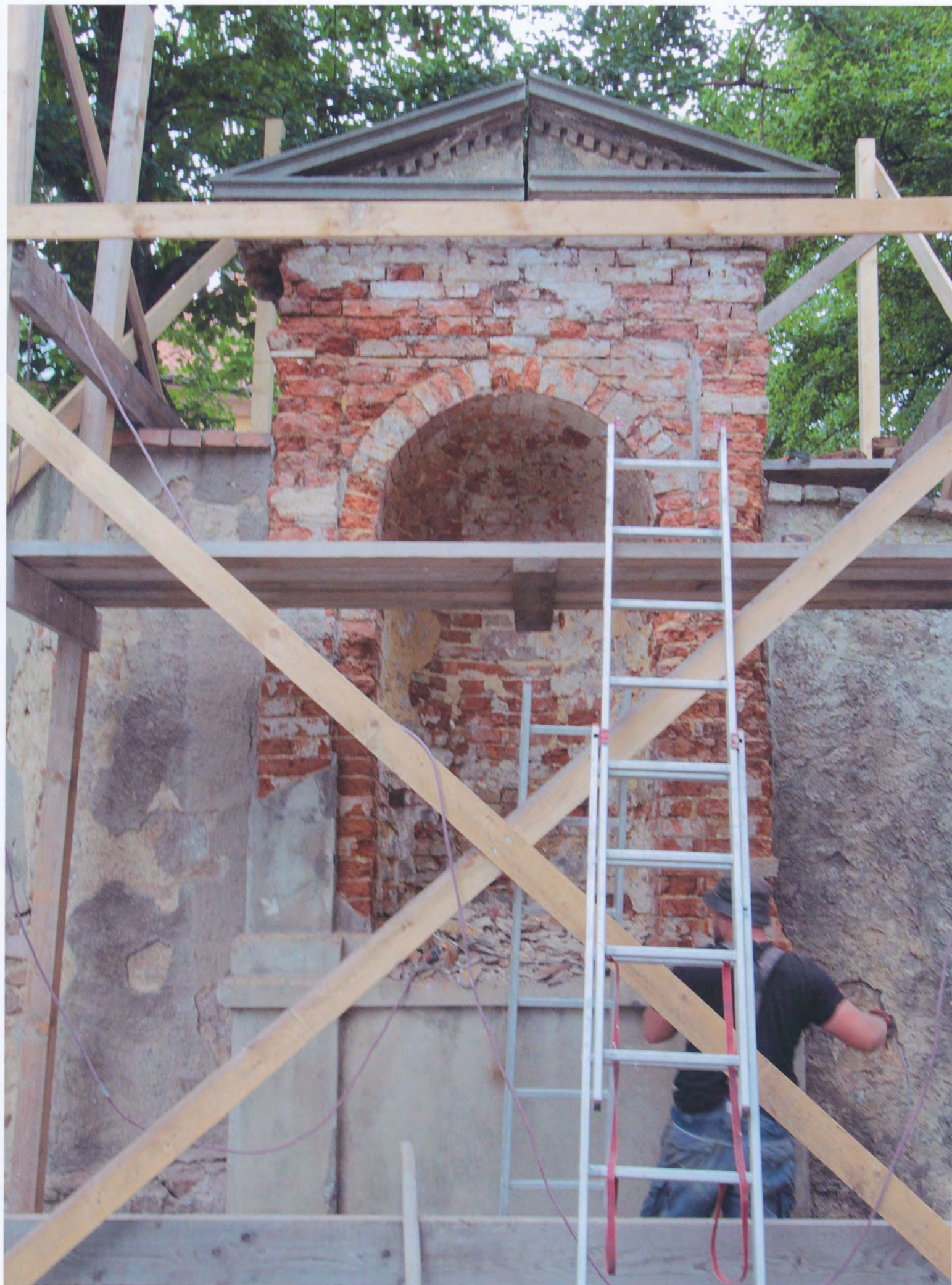
18. Liteň – Výklenková kaple se sochou v ohradní zdi kostela sv. Petra a Pavla – postup prací – odstranění cementové omítky z poslední opravy
