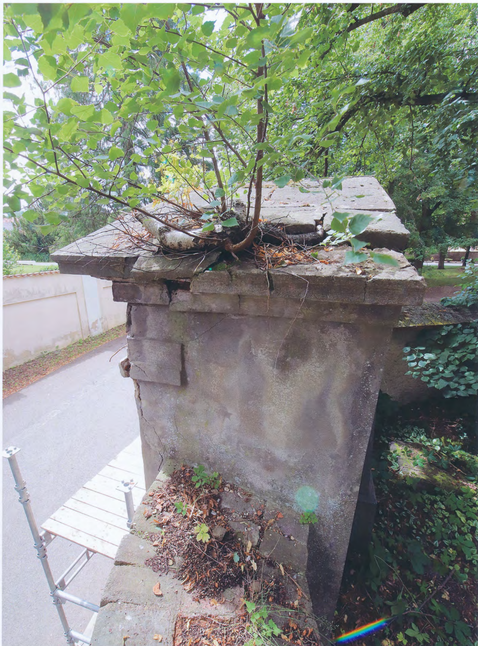
12. Liteň – Výklenková kaple se sochou v ohradní zdi kostela sv. Petra a Pavla – detail horní části, pravá strana - stav před restaurováním
