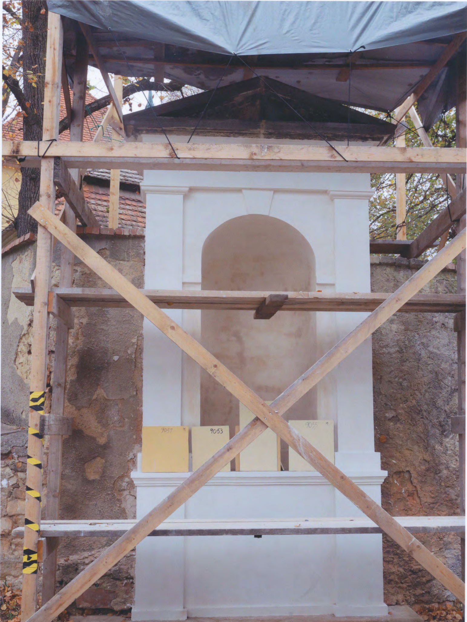
32. Liteň – Výklenková kaple se sochou v ohradní zdi kostela sv. Petra a Pavla – postup prací – dokončené rekonstrukce omítek s profilací a vzorkování odstínu vápenného nátěru
