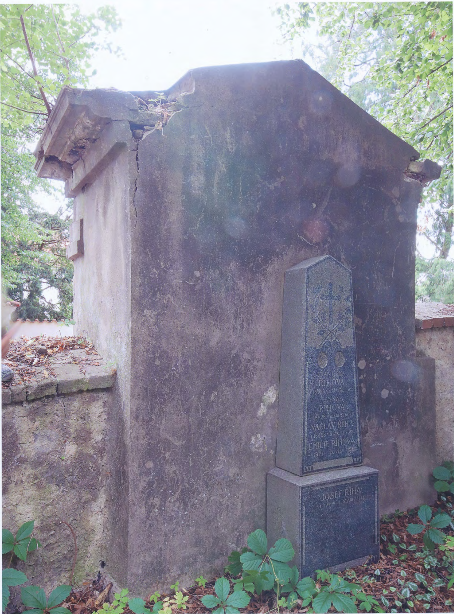
10. Liteň – Výklenková kaple se sochou v ohradní zdi kostela sv. Petra a Pavla – zadní strana, celek - stav před restaurováním
