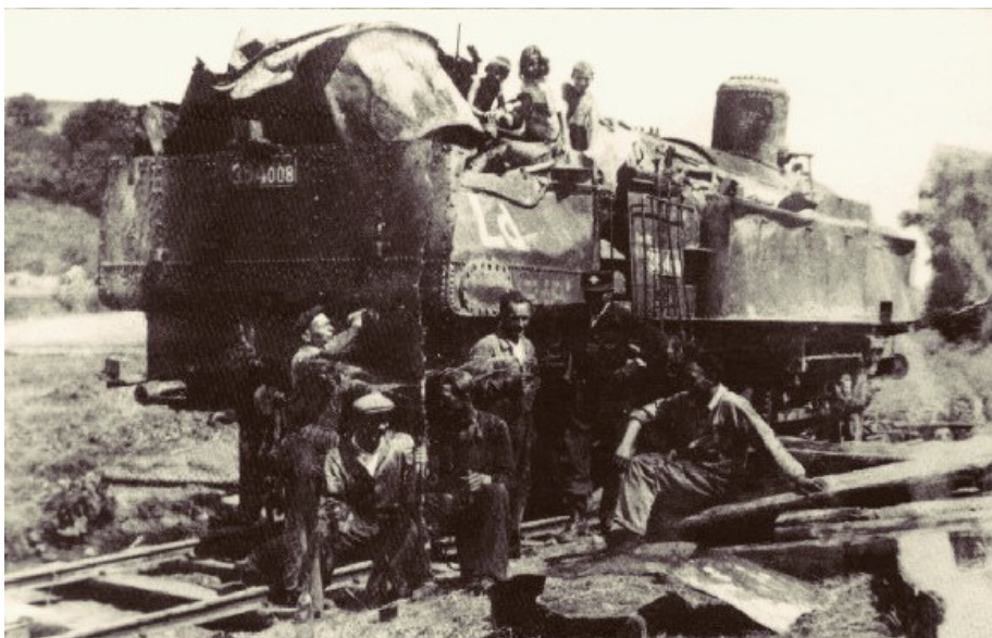
Zdemolovaná lokomotiva opět na kolech. Snímek pochází z léta 1945. Lokomotiva byla po dřevěné rampě vytažena zpět na trať a po náročné opravě se vrátila na koleje. FOTO: sbírka F. Klímy
